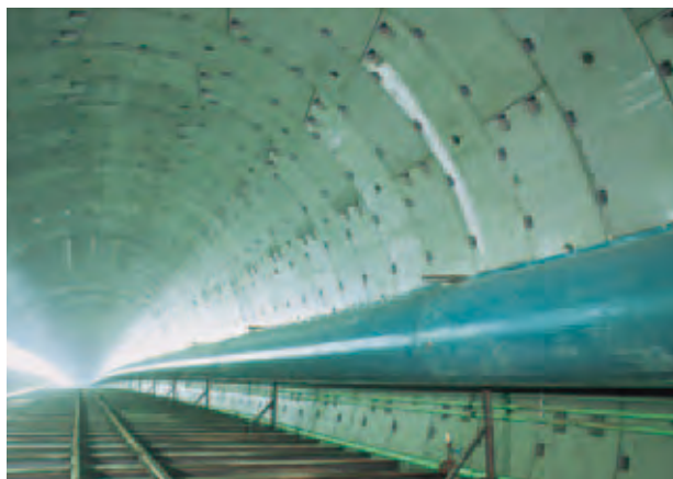
シールド工法でのファスナー式FST風管実用例
